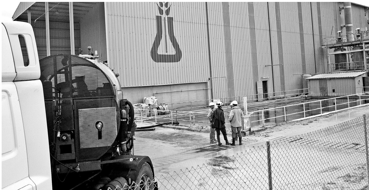
TRASLADO. Técnicos de Medio Ambiente y de la empresa supervisaron ayer el vaciado de la piscina con restos tóxicos. / RAFA GONZÁLEZ
